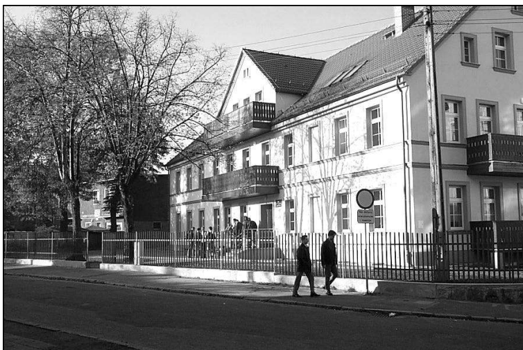
Fot.1. Budynek Instytutu Techniki przy ul. Cieplickiej 16.
