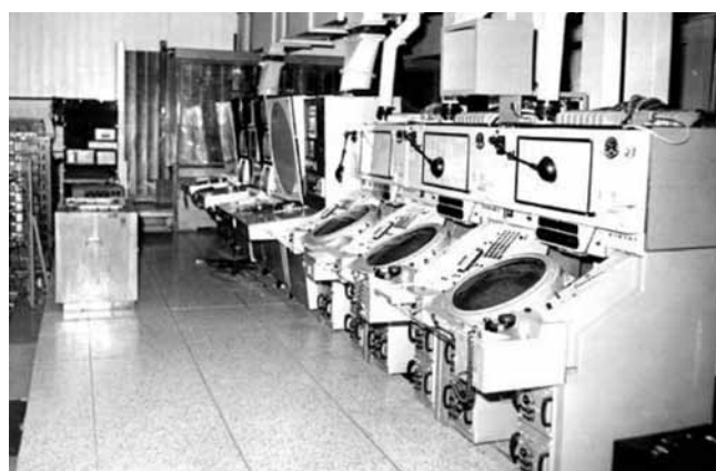
Fot. 8.9. Sala aparatury „Wozduch”
