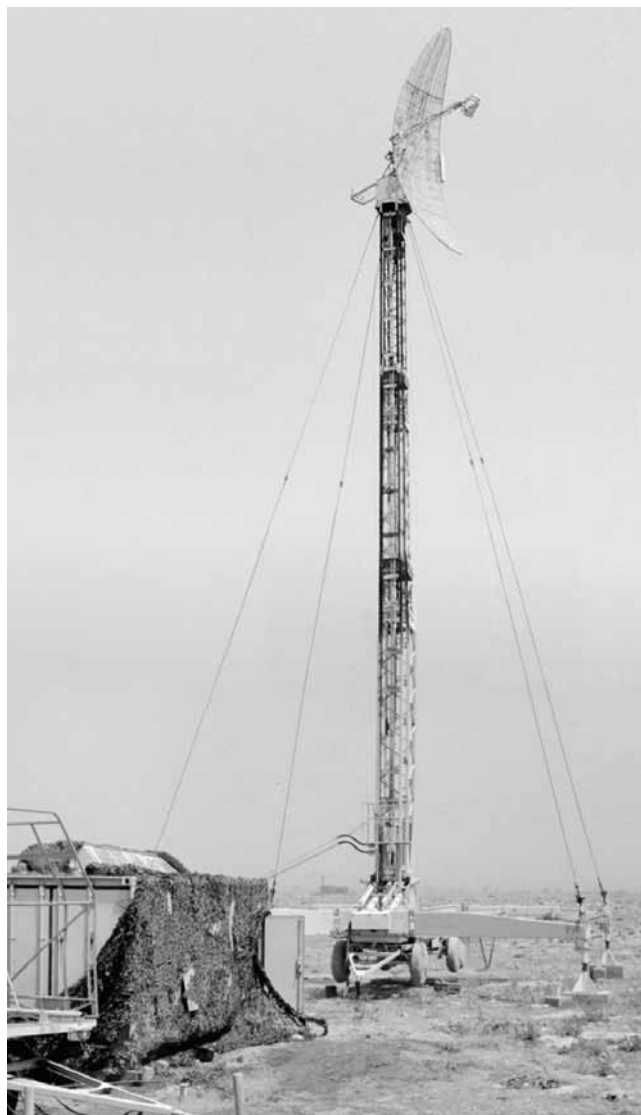
Fot. 7.29. Radar „Narew” (RT-17)
