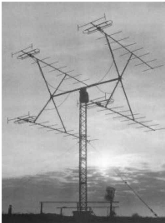
Fot. 7.6. Antena radaru P-10
