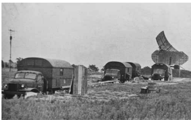
Fot. 6.101. Stacja P-25 na posterunku w ugrupowaniu 3. sbr w Ożarowie
