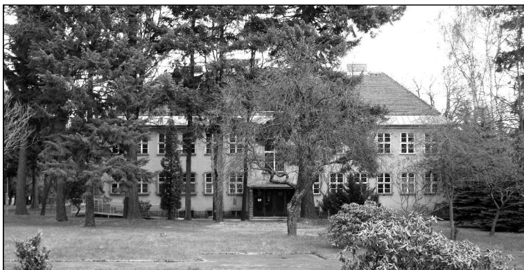
Budynek nr A/2
