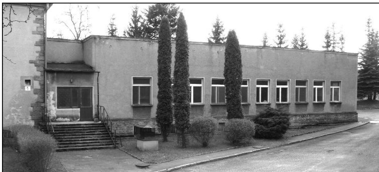
Przybudówka do budynku A/1
