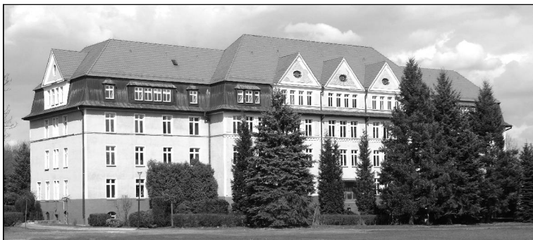
Budynek nr A/11.
