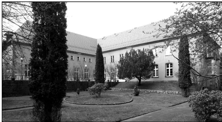
Budynek nr A/1
