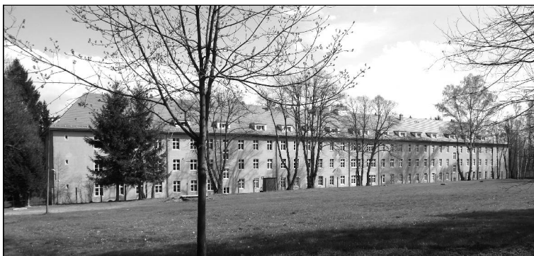
Budynek nr A/3
