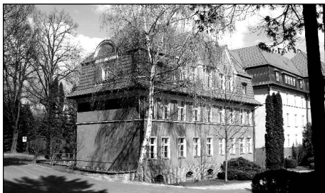
Budynek nr A/12.
