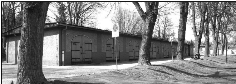
Budynek nr A/14
