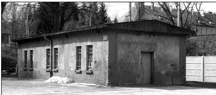
Budynek nr A/15
