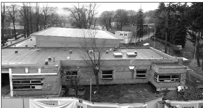
Budowa krytej pływalni wraz zapleczem dydaktycznym – stan na początek grudnia 2011 r.
