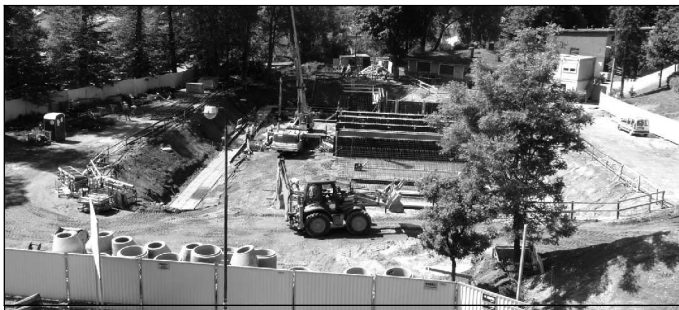
Budowa krytej pływalni wraz zapleczem dydaktycznym – stan na czerwiec 2011 r.
