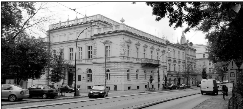
Budynek Klubu 2 Korpusu Zmechanizowanego - Kraków ul. Zybkiewicza 1
