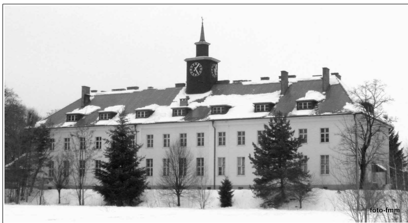
Budynek stołówki [B/15]
