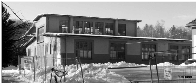
Budynek dawnej pracowni polowych zespołów prądotwórczych [B/20]
