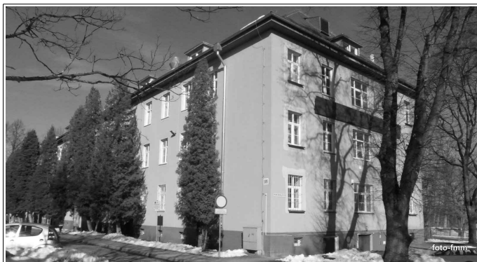
Budynek Starostwa Powiatowego w Jeleniej Górze [B/1]
