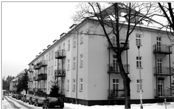
Budynki koszarowe przebudowane na budynki mieszkalne
